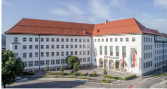
Hauptgebäude am Prinzregentenplatz
